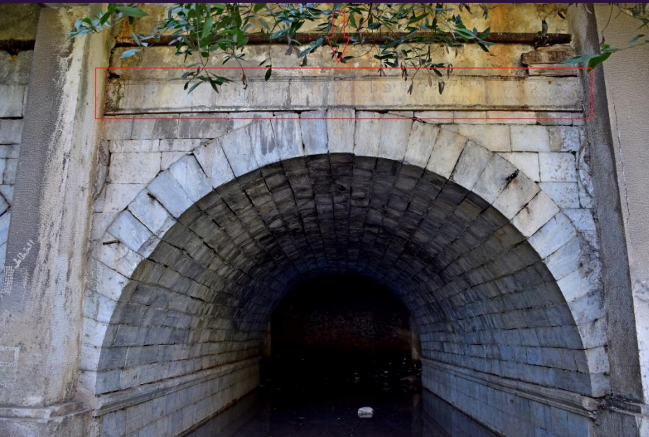
Λιθόκτιστη γέφυρα Ιλισού
